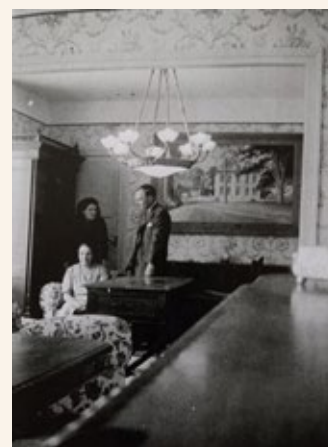
Vue de l'intérieur de la propriété.
